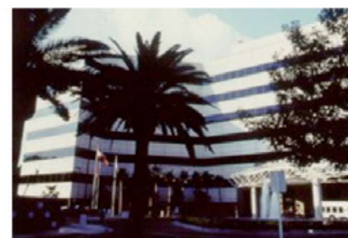
L'USC Hospital di Los Angeles (California, USA), isolato sismicamente
