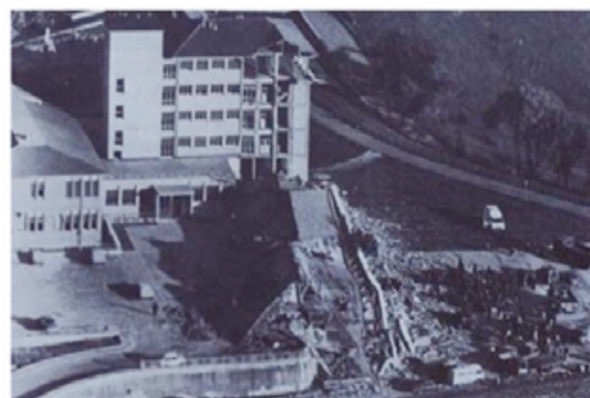
Figura 2- Collasso dell'Ospedale San Angelo dei Lombardi nel terremoto dell'Irpinia-Basilicata 1980
