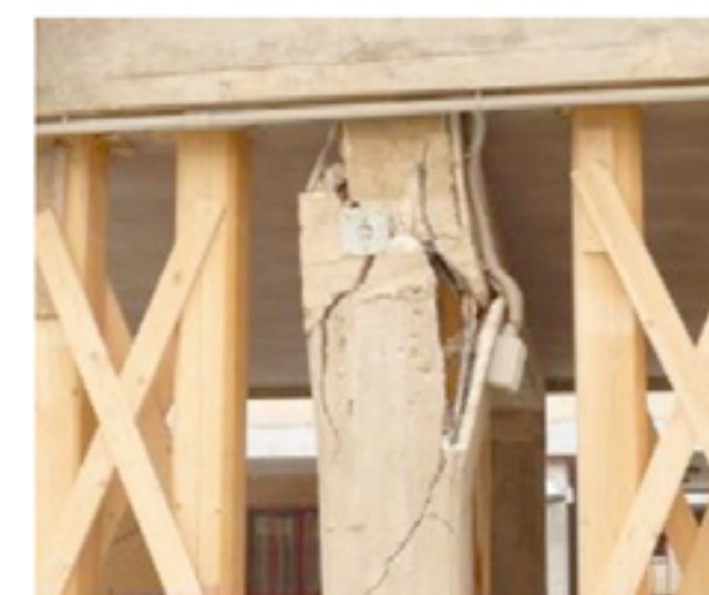
Figura 3 – Gravi danni strutturali ad un padiglione dell'ospedale San Salvatore de L'Aquila in seguito al terremoto del 2009.
